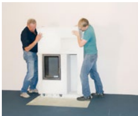
Verkleidungselemente Stück für Stück zusammensetzen und verkleben
