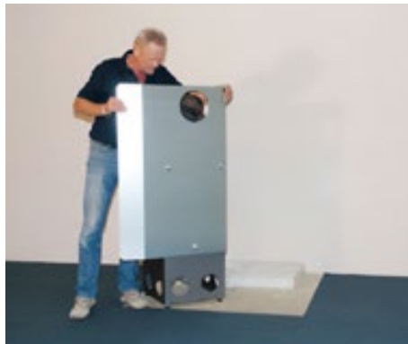
Wärmeschutzblech (Zubehör) montieren
